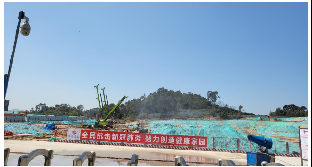
东莞市生物技术产业大厦工程一期
