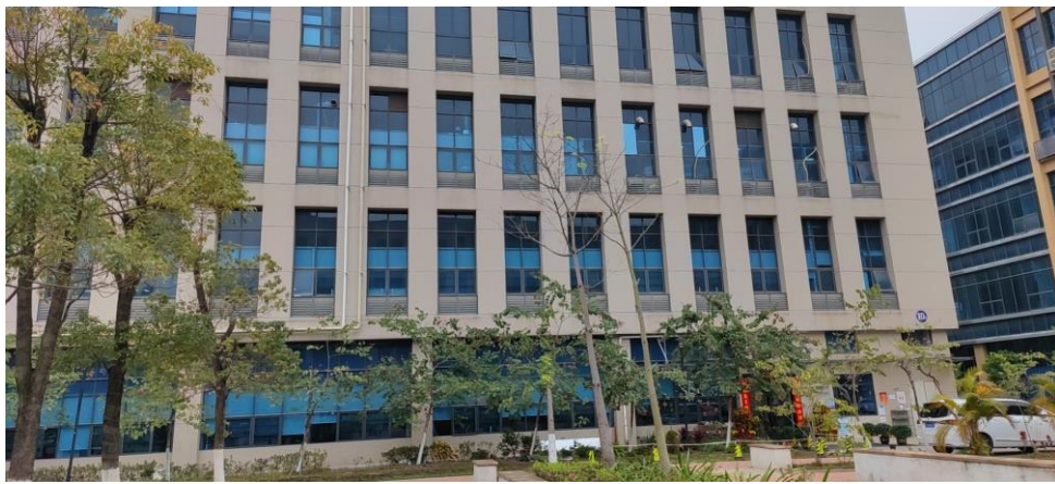
项目所在 10 栋厂房
