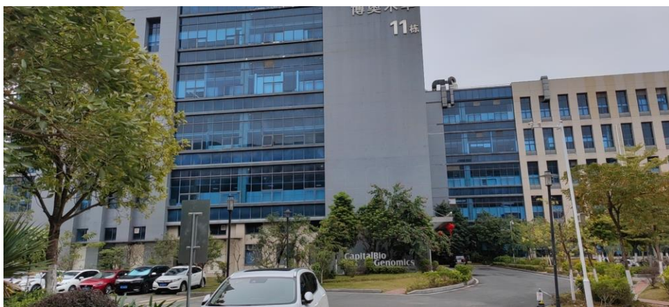
项目连体建筑 11 栋厂房
