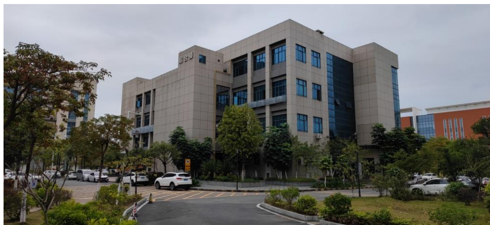
项目园区内综合楼
