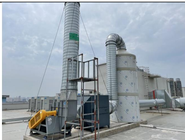
项目现有废气处理设施废气排放口
