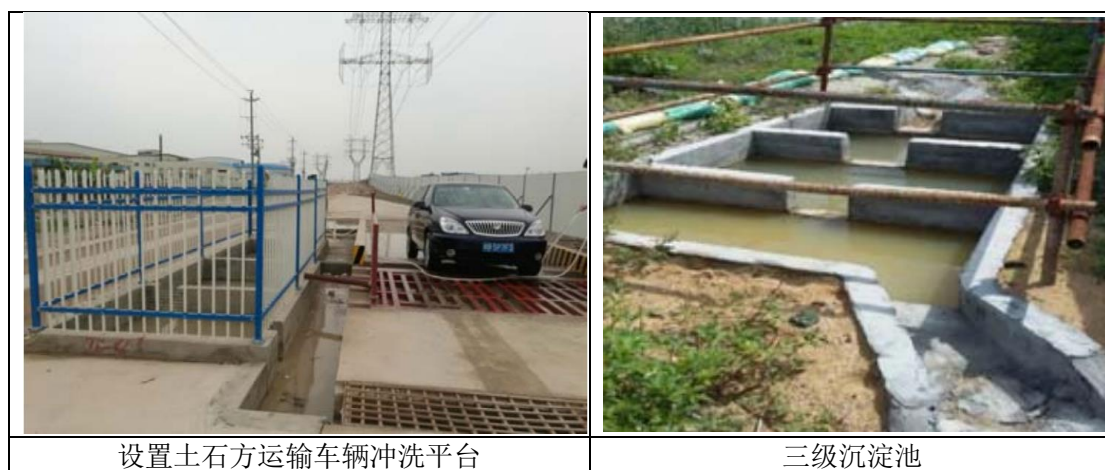
图7.2- 1 本项目施工期废水防治措施
