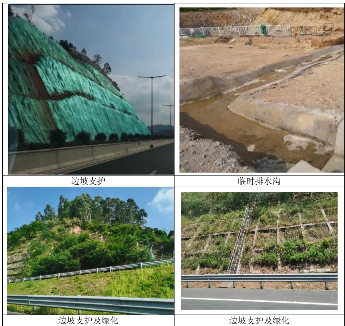
图5.3-1 项目施工期水土流失防止措施图
