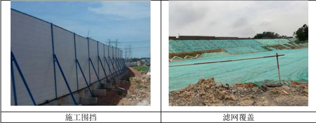
图8.3-1 项目施工期大气保护措施
