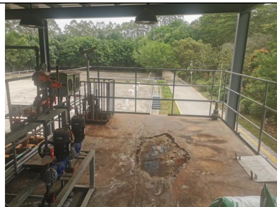
一级反硝化池
