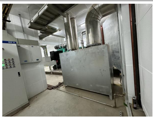
水浴式喷淋烟气净化器箱
