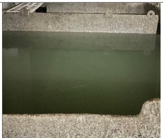
施工期污水沉淀池
