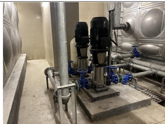
水泵房减震基座
