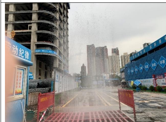
施工期自动循环洗车池
