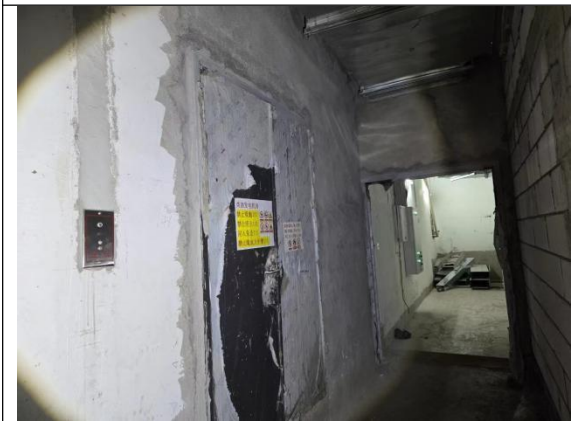
备用发电机房隔声门
