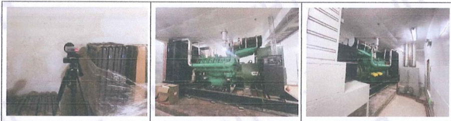
附 2: 现场检测照片
