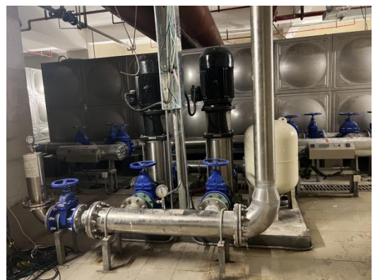
水泵房减震基座
