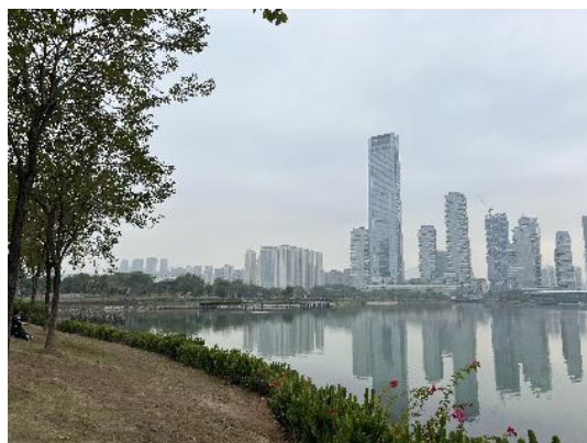
内湖重点区域清淤（近新建调蓄池）
