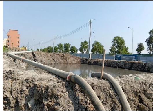
施工废水排入集水沉砂池
