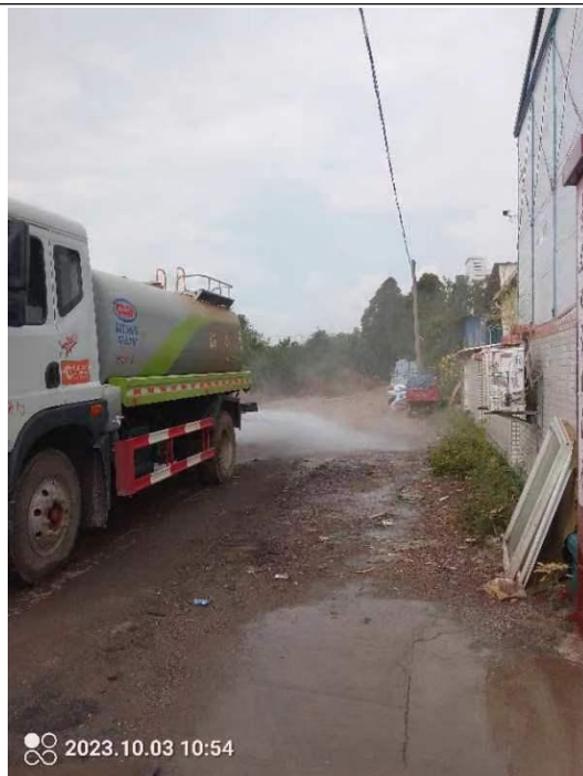
施工期清洗施工道路
