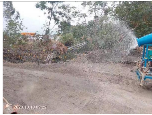
施工废水回用于施工洒水降尘、清洗道路
