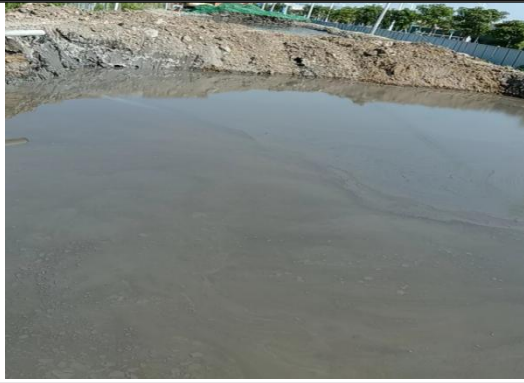
施工废水排入集水沉砂池
