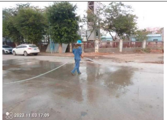
施工废水回用于施工洒水降尘、清洗道路
