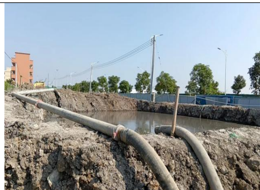
施工废水排入集水沉砂池
