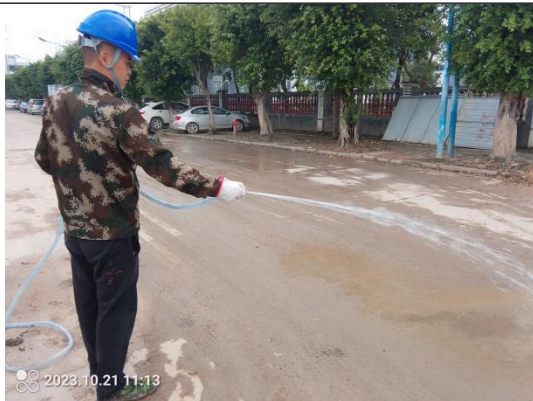
施工废水回用于施工洒水降尘、清洗道路
