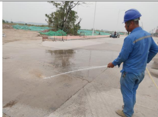
施工废水回用于施工洒水降尘、清洗道路
