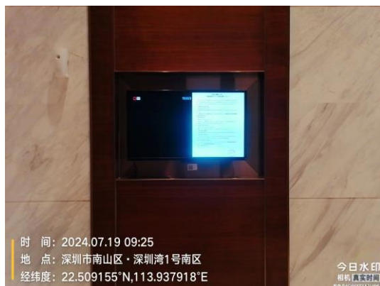
深圳湾1号南区电梯厅电子屏
