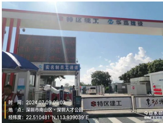
项目现场公告栏
