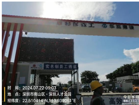
项目现场公告栏
