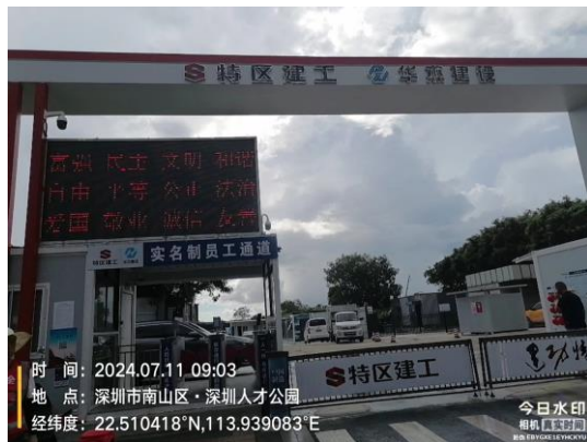
项目现场公告栏
