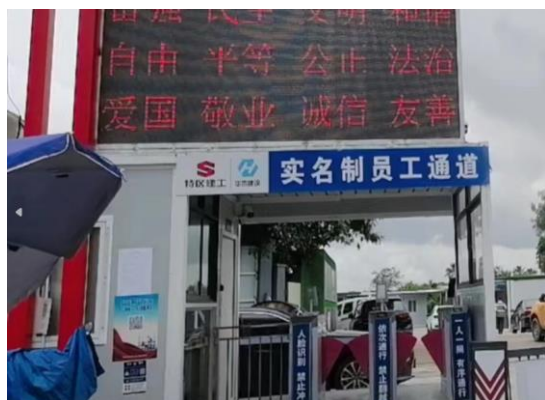
项目现场公告栏
