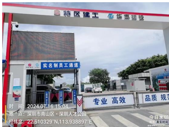
项目现场公告栏
