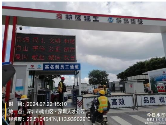
项目现场公告栏
