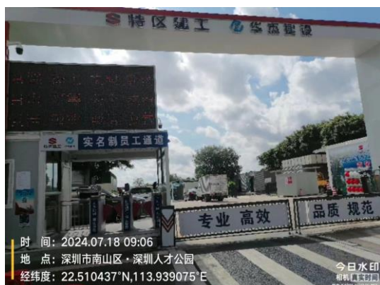
项目现场公告栏
